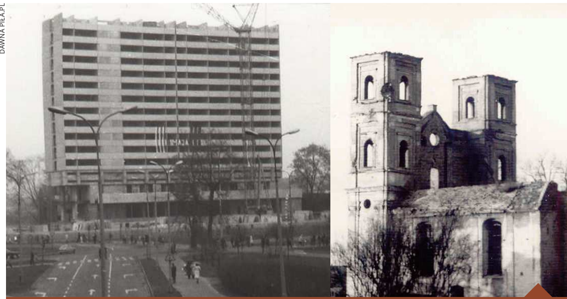
Hotel Gromada (dawniej Rodło), który stoi w miejscu ruin kościoła św. Janów, to symbol bezmyślnego niszczenia materialnych śladów kultury staropolskiej
