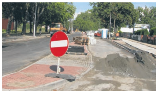
Prace na ul. Kossaka zbliżają się do finału
