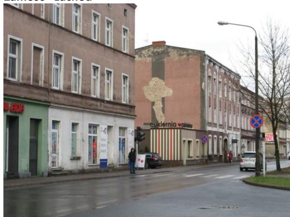
Zdjęcie 4. ul. Ludowa w Pile – podobszar rewitalizacji Zamość - zachód
