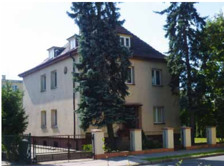
Budynek przy ul. Tucholskiej 9, fot. z 2012 r.
